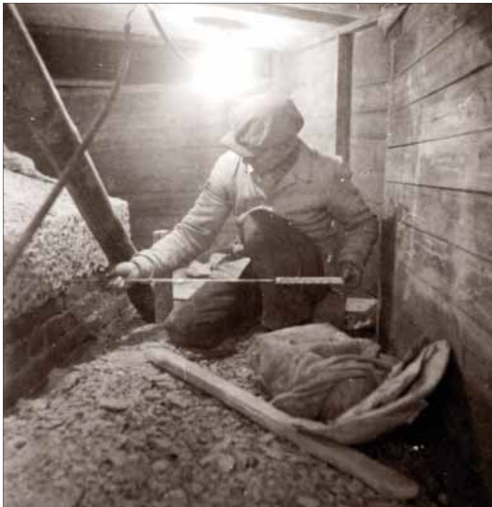
Spektakuläre Aufnahmen vom Fundament des Reichturmes entstanden bei seiner Stabilisierung durch das Bautzener Unternehmen Hentschke im Sommer des Jahres 1953.
