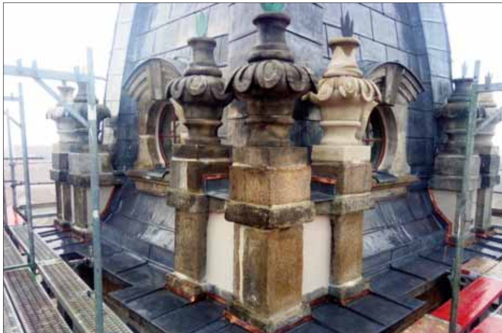
Die Turmhaube wurde aufwändig verbleit, eine denkmalgerechte und dauerhafte Lösung.
